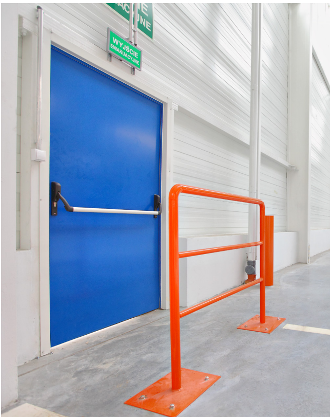
Drzwi stalowe płaszczone przeciwpożarowe z dźwignią antypaniczną
